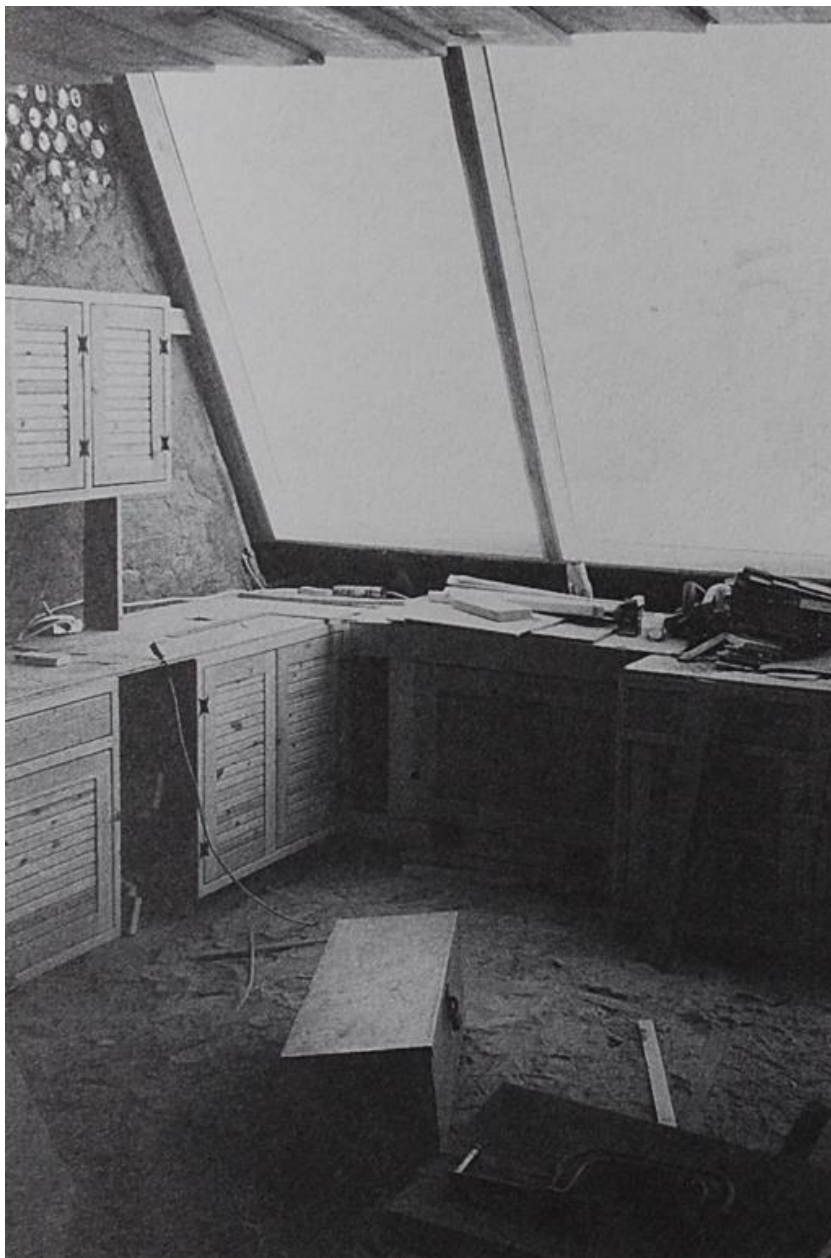
HORNO SOLAR EN CONSTRUCCIÓN
